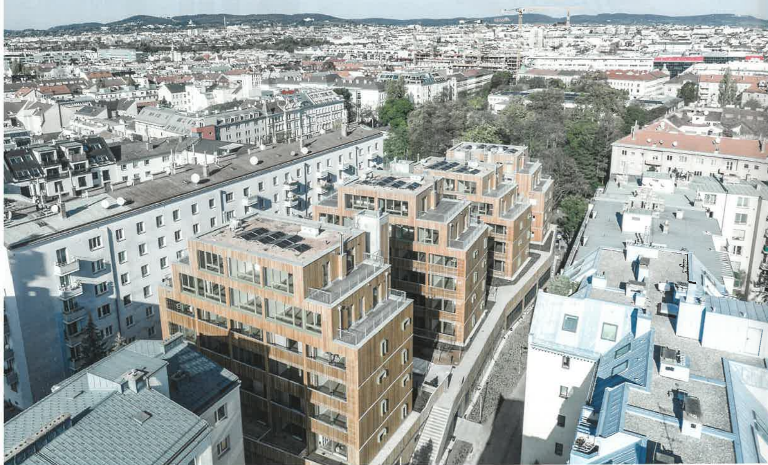
„Woody-M“ im 12. Wiener Gemeindebezirk: Vier locker positionierte Baukörper stehen am intensiv begrünten Sockelgeschoss.
