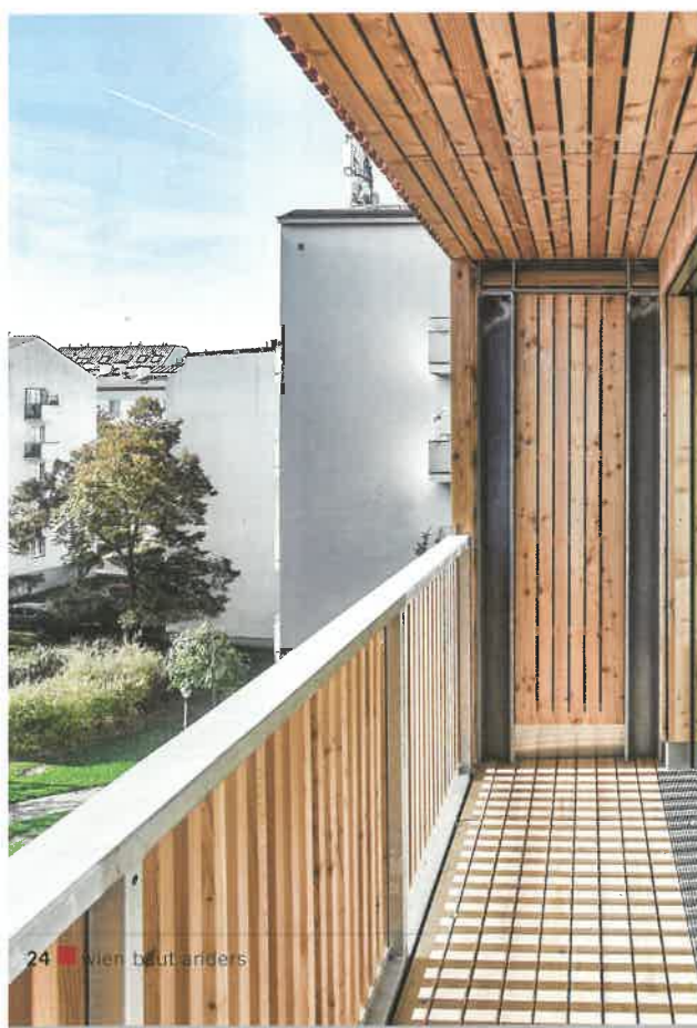
Vorgelagerte Loggien und Laubgänge lösen die Fronten auf und geben Blicke Richtung Süden oder auf den Christine-Busta-Park frei.
